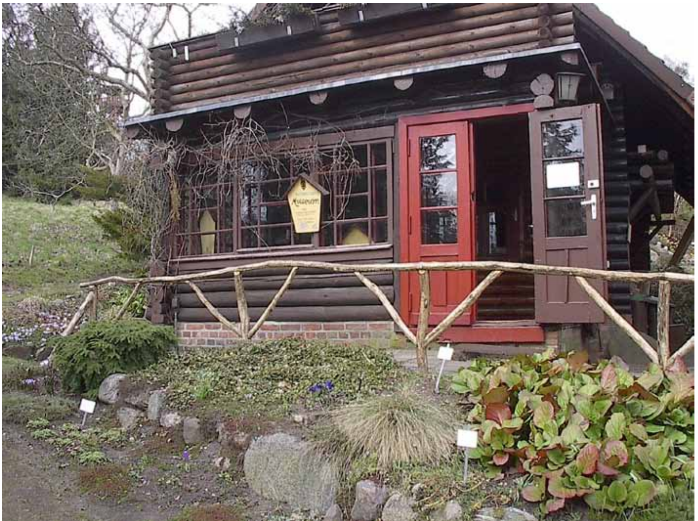
Blockhaus in Bad Freienwalde (Erstes Wohn- und Arbeitshaus von Erna und Kurt Kretschmann) April 2006
